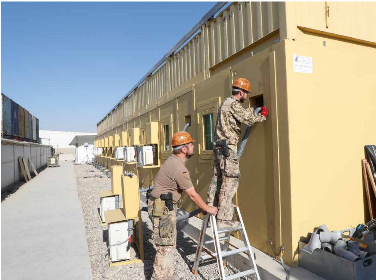
Arbeiten an der Klimaanlage eines Unterkunftcontainers
