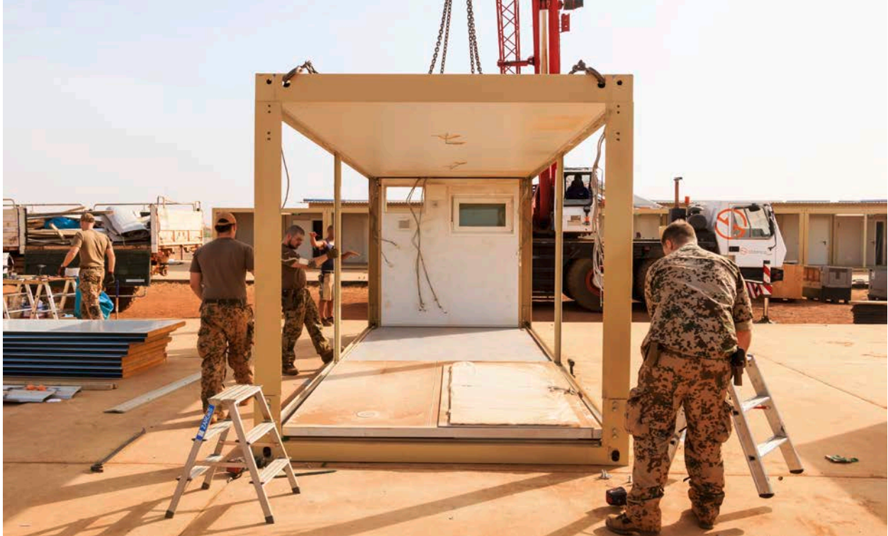
Soldaten des Spezialpionierregimentes 164 bauen einen Wohncontainer auf
