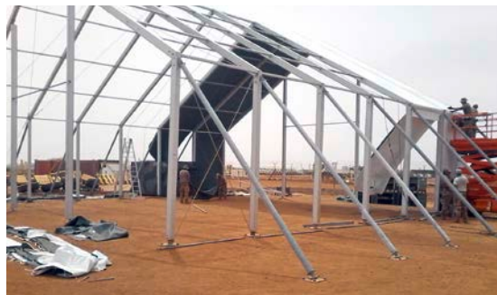
Aufbau eines Instandsetzungszeltes
